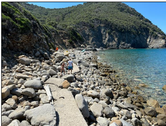
Foto 3 - Dettagli del camminamento in calcestruzzo che attraversa l'arenile di patresi. Si notino i localizzati danneggiamenti dello stesso, causati in gran parte della caduta di materiale lapideo dal versante sovrastante.
