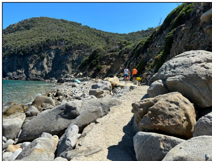
Foto 4 - Dettagli del camminamento in calcestruzzo che attraversa l'arenile di patresi. Si notino i localizzati danneggiamenti dello stesso, causati in gran parte della caduta di materiale lapideo dal versante sovrastante.
