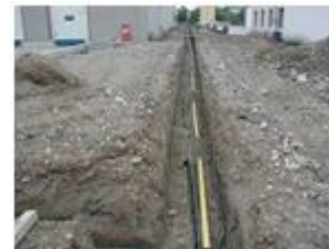
SCAVI E LAVORI EDILI
