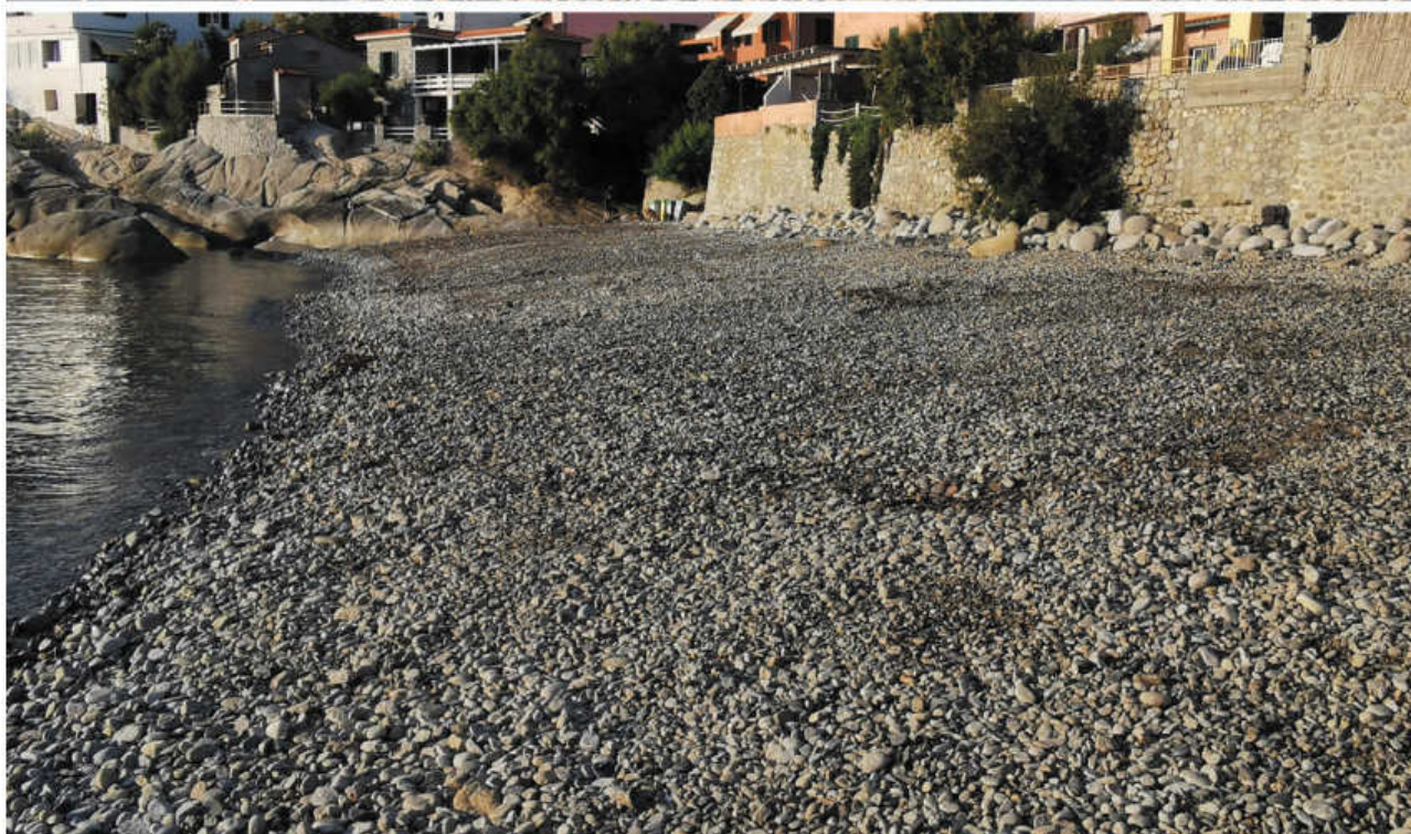
Foto n. 1 e 2 – La spiaggia di Pomonte da S, prima e dopo l'intervento. Il pietrisco di Monzogranito del M.te Capanne è stato inserito e poi ricoperto con i ciottoli di spiaggia. Parte dei massi presenti nel corpo spiaggia sono stati posizionati alla base del muro di contenimento delle corti e dei giardini delle abitazioni soprastanti per ridurre gli impatti delle onde di tempesta in risalita.
