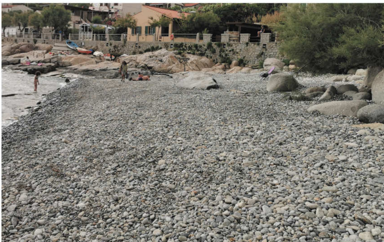
Foto n. 6 e 7 – La spiaggia di Chiessi da S, prima e dopo l'intervento. Il pietrisco di Monzogranito del M.te Capanne è stato inserito e poi ricoperto con i ciottoli di spiaggia. Parte dei massi presenti nel corpo spiaggia sono stati posizionati alla base del muro di contenimento della strada lungomare retrostante per ridurre gli impatti delle onde di tempesta in risalita.
