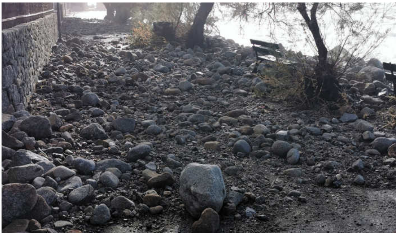
Foto n. 6: dopo la mareggiata da Ponente, subito dopo il ponte, verso S, la strada invasa dagli inerti provenienti dalla spiaggia di Pomonte , che obiettivamente si impoverisce. Anche se una successiva sciroccata ne riporterà indietro una parte, in assenza di strutture rigide di contenimento laterale della spiaggia la dispersione sui fondali è inevitabile.
