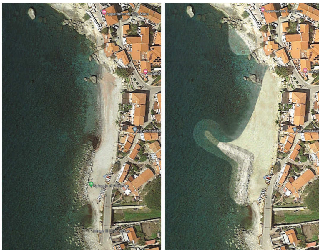
Fig. 10 – Il litorale di Pomonte prima e dopo gli interventi di progetto.
