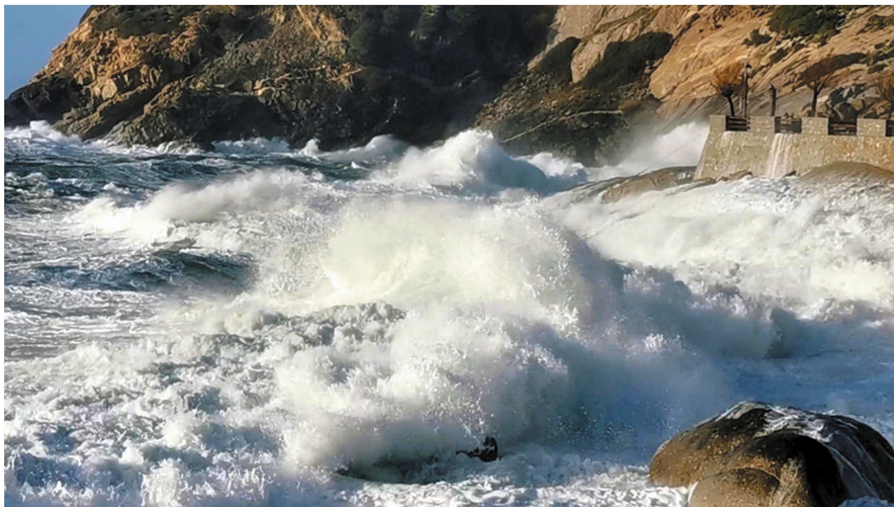
Foto n. 3 – Il frangimento di onde durante una mareggiata di Ponente di intensità medio-forte, dove sarà posizionata la nuova barriera radente lato N. Notare la risalita delle onde a circa 4 m, come da calcoli (v.)
