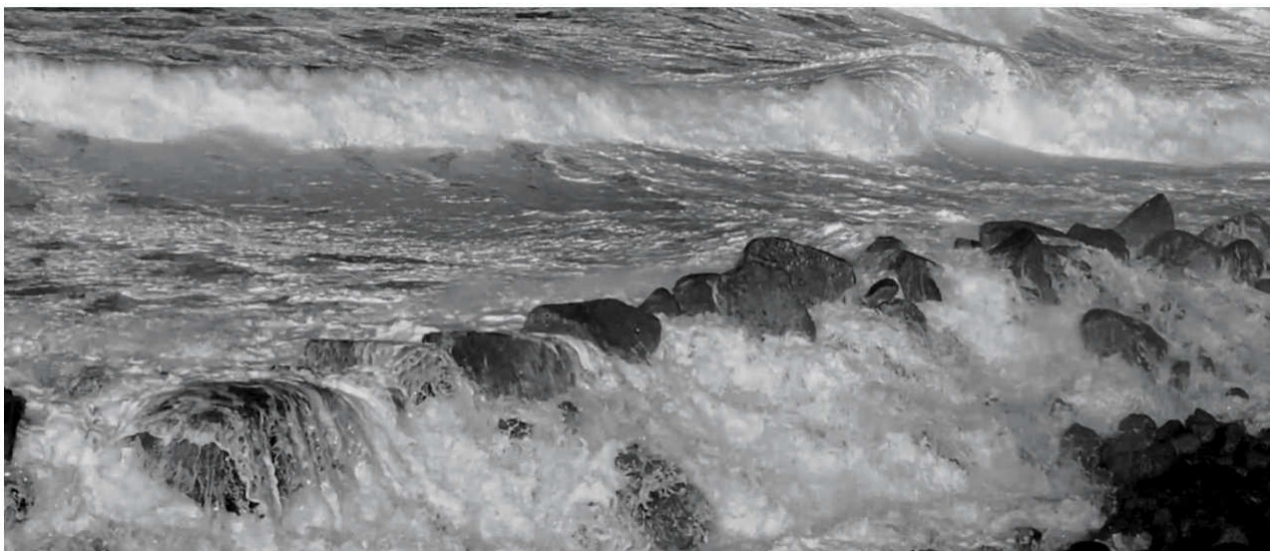
Foto n. 1 – La barriera esistente a Pomonte, facilmente sormontata dalle mareggiate
