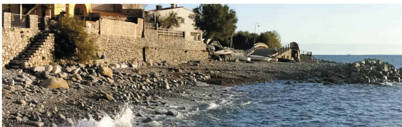
Foto n. 4: Dopo la sciroccata, la parte S della spiaggia è pericolosamente ridotta, in termini di larghezza e spessore di sedimenti
